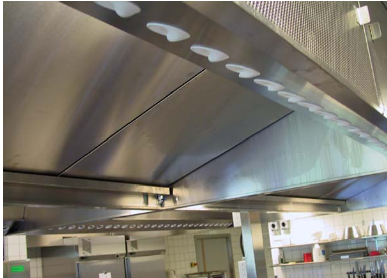
Sefokåpa typ BK, EK, och EDK är beteckningen på våra volymkåpor typ B, E och ED när de kompletteras med kondensplåtar för bättre kondensuppfångning.
